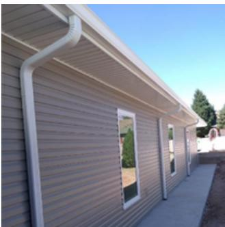
Los canalones y bajadas son un sistema de drenaje que ayuda a eliminar el agua del techo en caso de lluvias, debido a que el agua de lluvia se redirecciona de manera efectiva a un lugar específico. De esta manera aseguramos la durabilidad y funcionamiento de la estructura.
